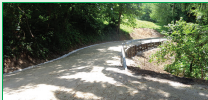
Območje sanacije plazov po obnovljenih delih
